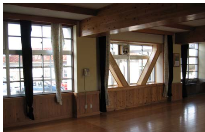
鉄骨ブレース増設（補強後）
