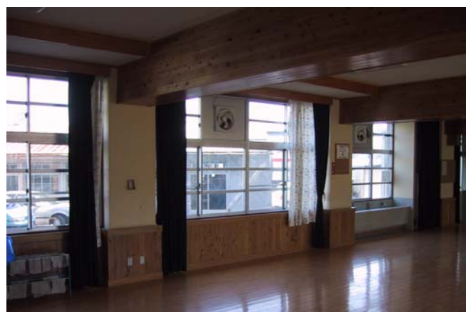
鉄骨ブレース増設（補強前）
