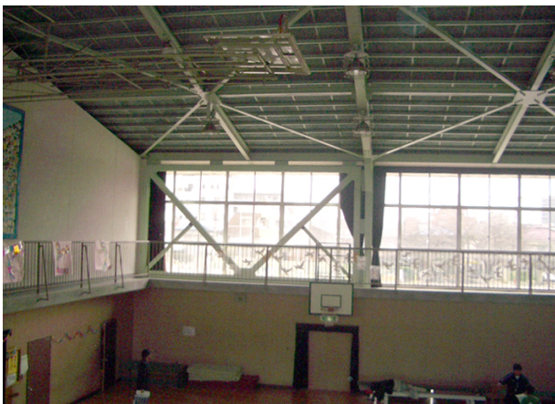
壁面鉄骨ブレース詳細
