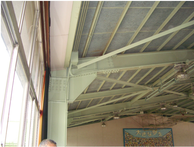
柱、梁仕口部のリブプレートによる補強
