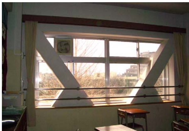
鉄骨ブレース補強
