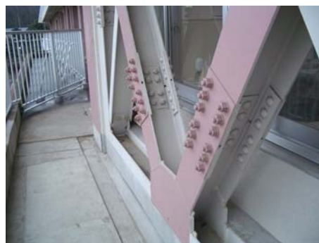
鉄骨ブレース補強詳細
