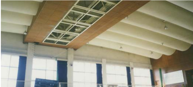
中央の梁部分と PC 屋根
