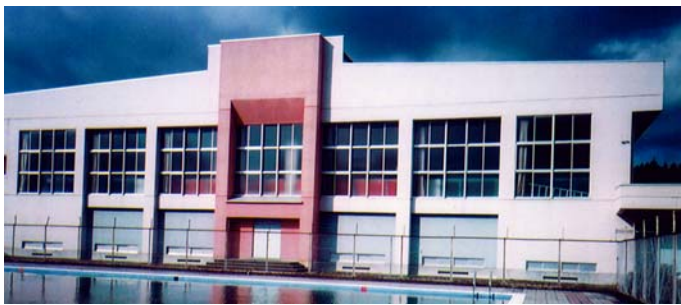
補強後の外観
