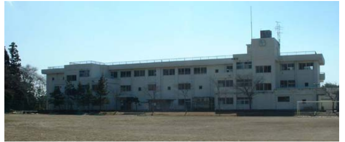
■補強後（北校舎）
