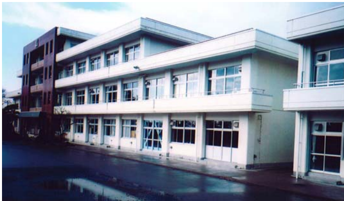
■補強後（南校舎）
