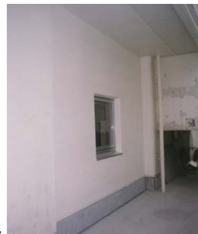
耐震壁部分内観
