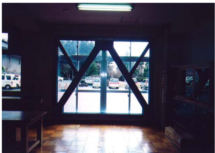
内部から見た鉄骨ブレース補強部
