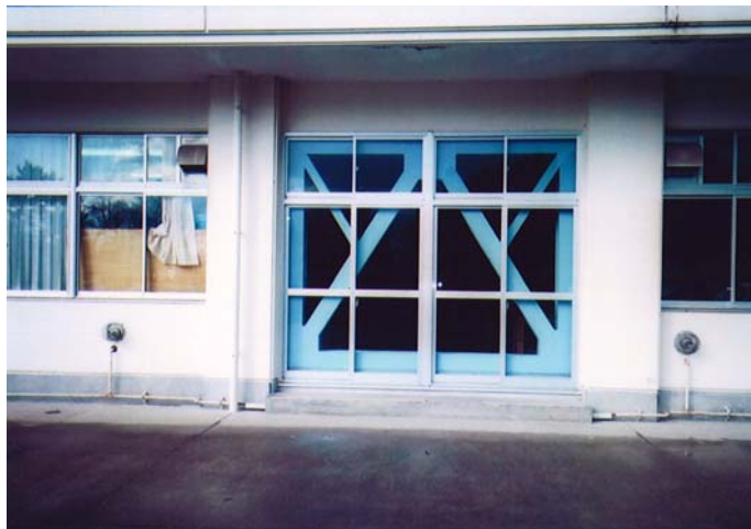
鉄骨ブレース補強部
