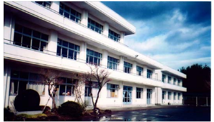
■補強後（南校舎）
