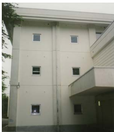
耐震壁部分外観
