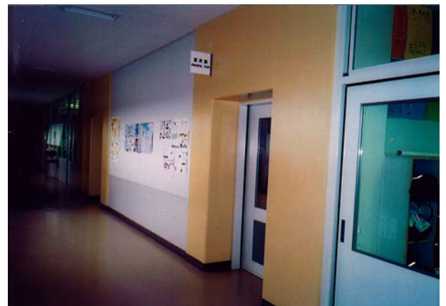
廊下側から見た補強部
