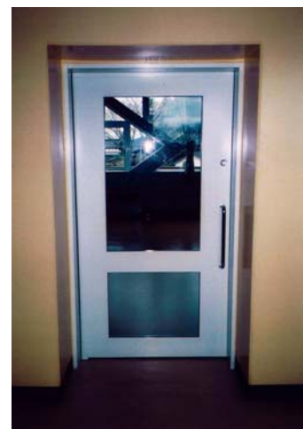
耐震壁部出入口
