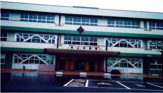
正面補強部分
