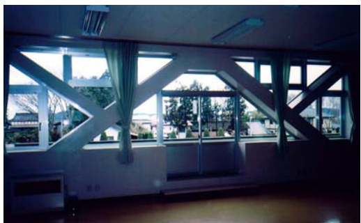
室内から見た補強部
