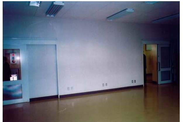
教室内から見た補強部
