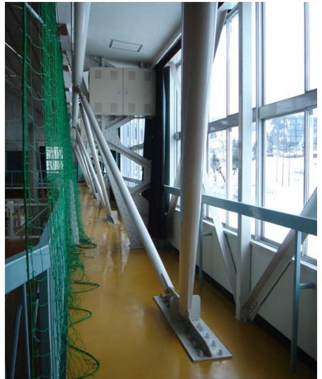
鋼管ブレースのアンカー部
