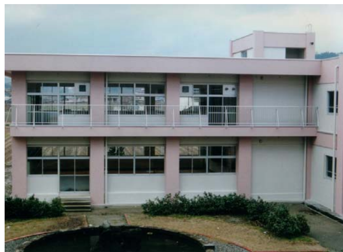
■補強後（特別教室棟 西側）
