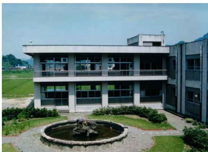
■補強前（特別教室棟 西側）
