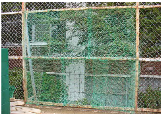
応急補修されたフェンス
