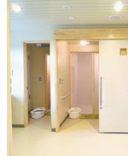
段差がないシャワー室
