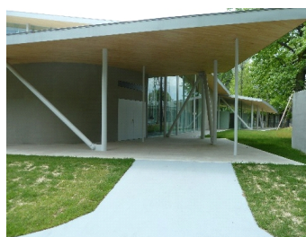
大きな庇(ひさし)空間
