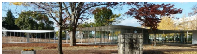
Junko Fukutake Terrace 東側外観
