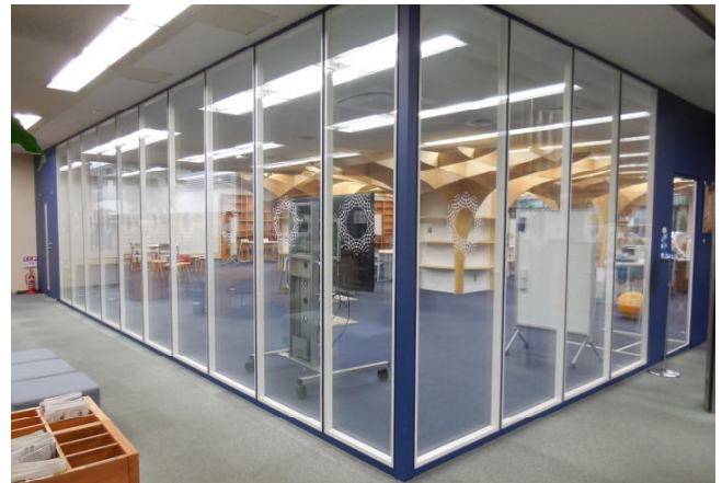
ラーニングcommonsの間仕切り
