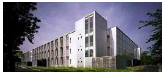
総合教育棟北東側外観
