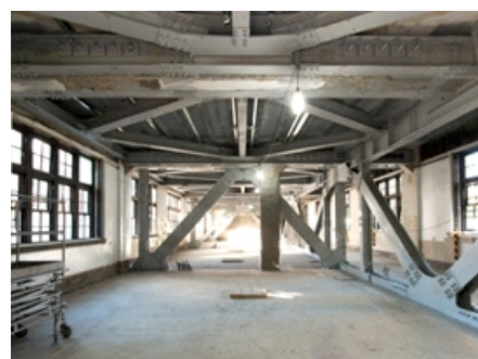
本館・鉄骨ブレース設置状 況
