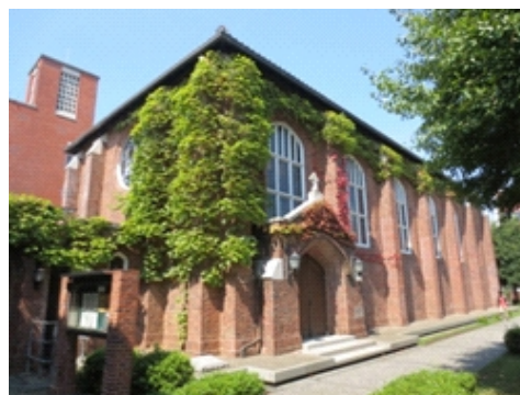
礼拝堂南東側外観
