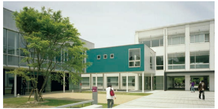
情報学習プラザと総合教育棟の接続
