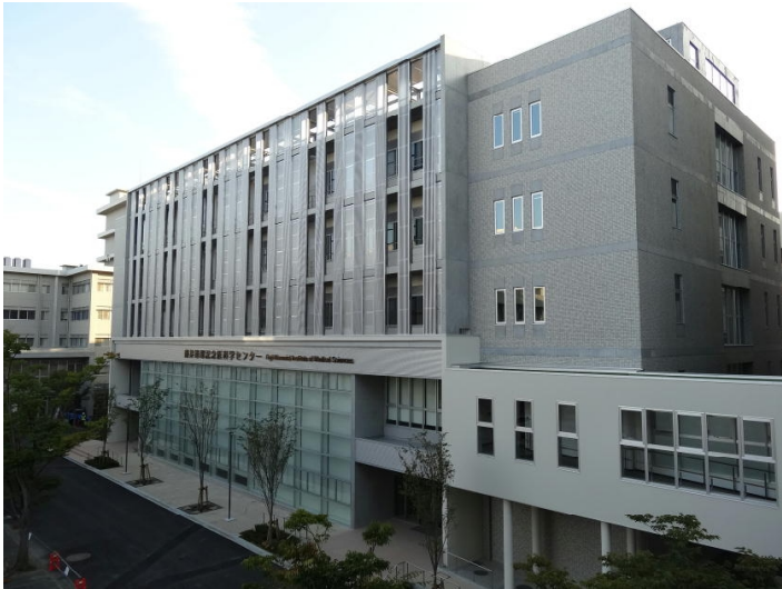
南西側外観（既存建物との外観を統一）
