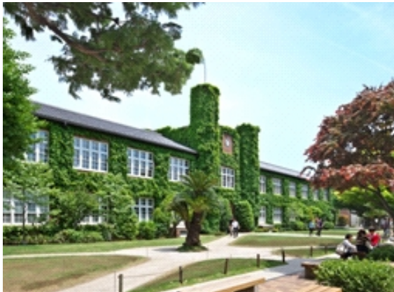
本館南側外観
