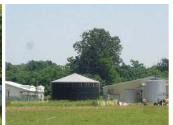
バイオガスプラント
