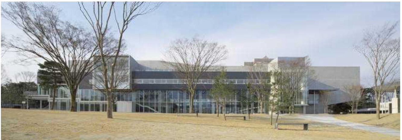
東キャンパスセンタースクエアーリニア棟北面外観
