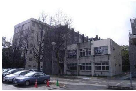
支障建物撤去前
