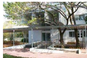
物質工学科化工・安工棟パーゴラ
