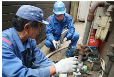
ガス工事現場の派遣社員
