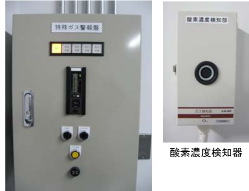
ボンベ庫には酸素濃度検知器を設け、ガスが漏洩した場合に警報が鳴るようにしている。
