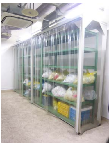
産業廃棄物保管室 薬品を拭き取った布等が保管されている。 気化した薬品が拡散しないよう上部から排気 している。
