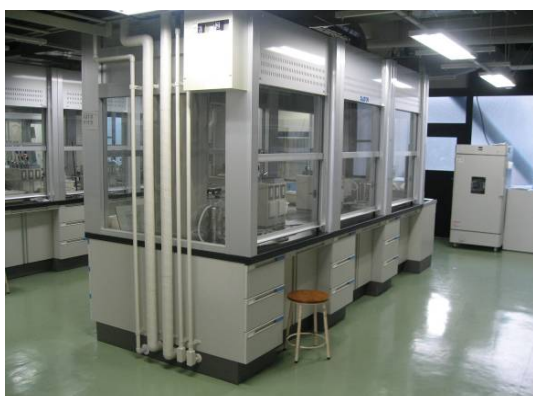
実験台全体を排気フードで覆い化学物質等のばく露を防いでいる。
