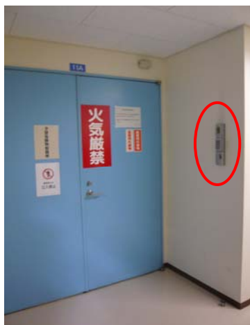
共通薬品貯蔵室 扉は指紋認証式の電子錠で入室管理 されている。
