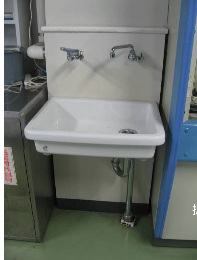
洗面器と洗眼装置を一体的に設けている。
