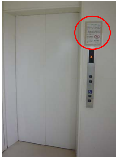
エレベーターの乗り場に液化ガスとの同乗禁止の表示がされている。
