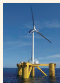
浮体式洋上ウインドファーム実証研究事業（経済産業省提供）
