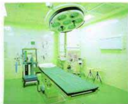
図 8 手術室の床と壁に光触媒タイルを使用
