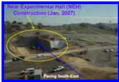
実験・研究棟建屋工事 (2007年1月撮影)
