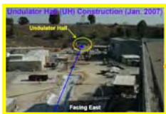
光源収納部建屋工事 (2007年1月撮影)
