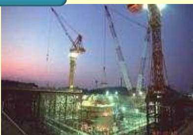
原子炉格納容器の設置
