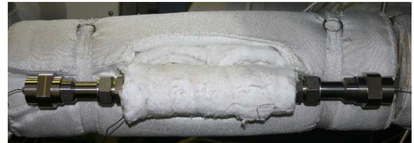
超音波式流量計 (センサ部)
