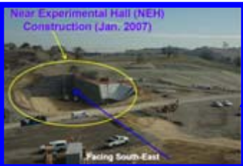
実験・研究棟建屋工事 (2007年1月撮影)
