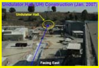
光源収納部建屋工事 (2007年1月撮影)
