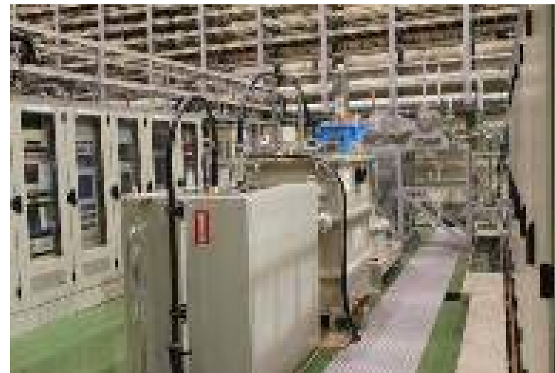
順調に据え付けが進む地上部の高周波機器類
