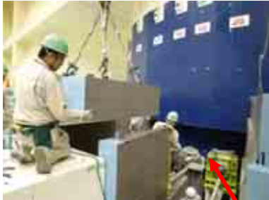
ずれた遮蔽体の積み直し作業 約530個、総重量約2,800トン
