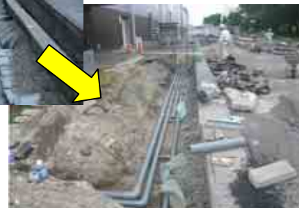
現在も復旧工事中
