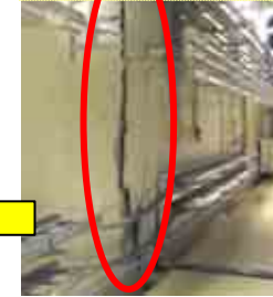
ビーム輸送トンネルで大亀裂
