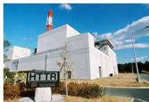
高温工学試験研究炉 (HTTR) (2019年10月 運転再開予定)
