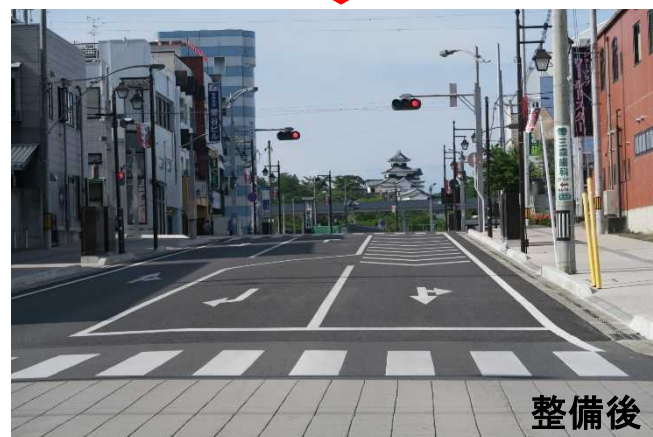
景観に配慮した道路整備
