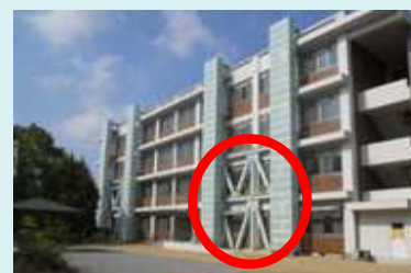
施設の耐震化(耐震ブレースを設置)
