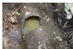
配管の腐食
