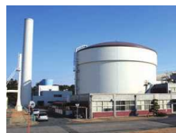
JRR-3 (2020年10月 運転再開予定)
