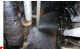
配管の破損による水漏れ
