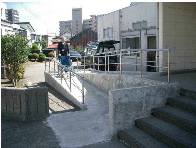
①スロープの設置
