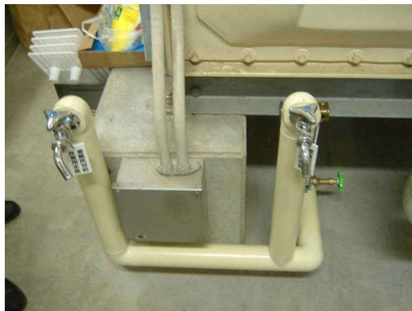
④受水槽蛇口設置
