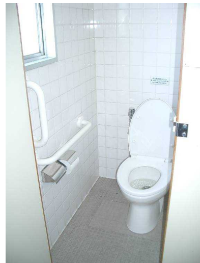
②洋式便器の設置
