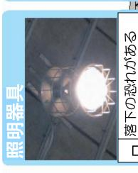
(照明器具に変形・腐食等 の異常, 器具カバーのは ずれが見られる) 周辺立入禁止 腳 89
