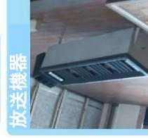
(機器の傾き,取り付け部 に腐食・破損が見られる) 落下の恐れがある ない **6**9
