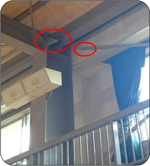
◆体育館ブレース破断、変形(豊田小)
