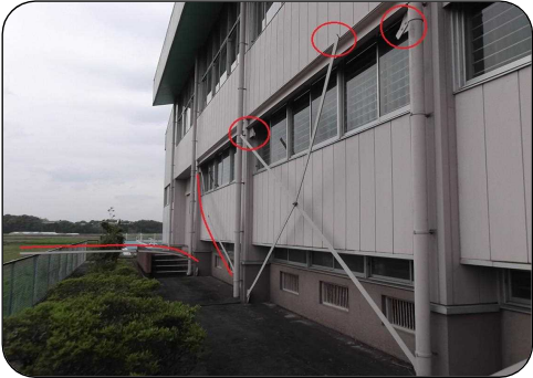
◆体育館ブレース破断、変形(豊田小)
