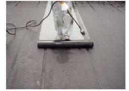
かぶせ工法による屋上防水改修
