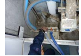
オゾン洗浄水方式による給水管洗浄
