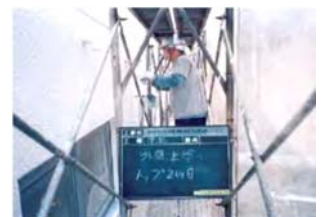
塗装・吹付け直しの例 (出典: マンションリフォーム推進協議会)
