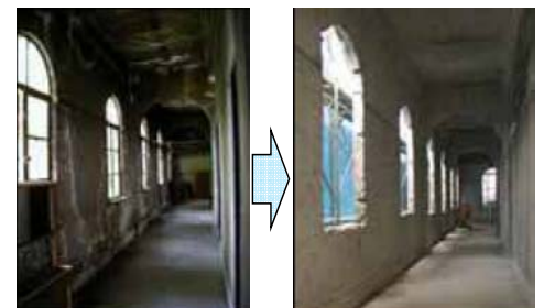
求道学舎(築後約80年)の躯体改修
