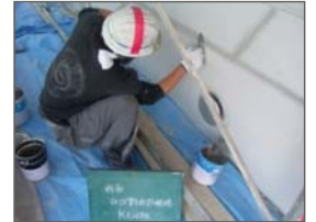
充てん工法によるひび割れ補修
