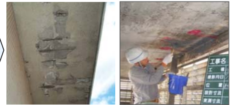
断面修復工法による補修
