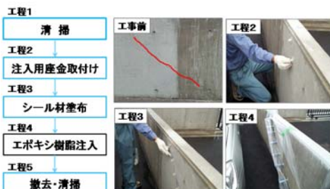
ひび割れの補修事例
