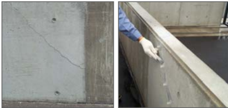
注入工法による補修
