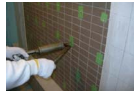
アンカーピンニング・注入併用工法によるタイルの浮きの補修
