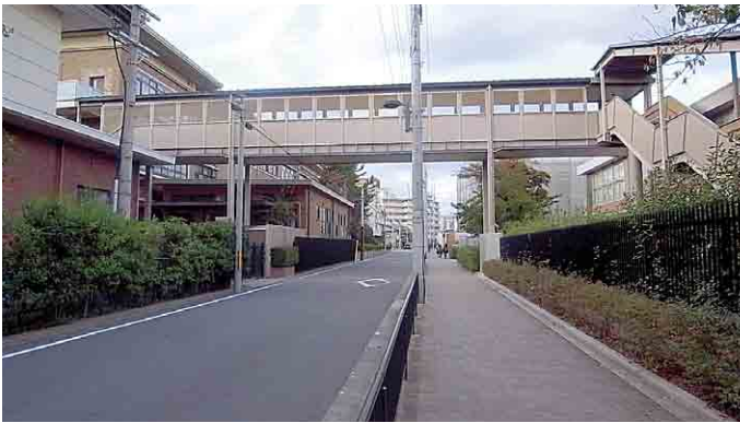
西エリアと東エリアを結ぶ連絡通路
