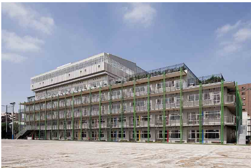
グラウンド側から見た校舎外観
