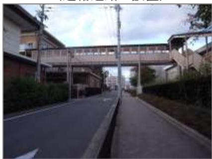
京都教育大学附属京都小中学校 「隣接する施設をつなぐ連絡通路」
