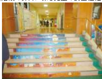
東山泉小中学校(東学舎) 「既存の中学校校舎の階段段差の改善」
