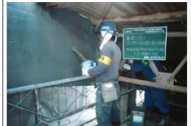
(下) 鉄筋コンクリートの長寿命化工事 (中性化対策)
