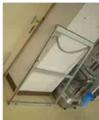
落下した障子
