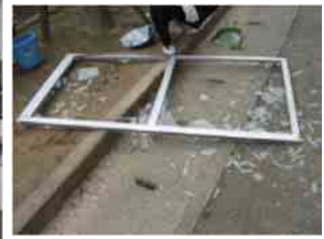
落下して破損した障子
