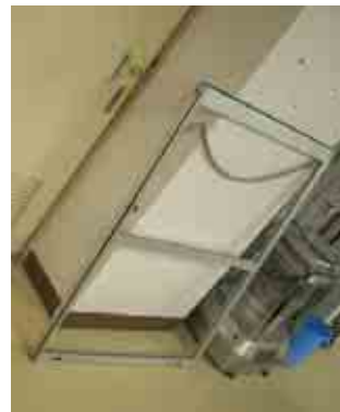
落下した障子
