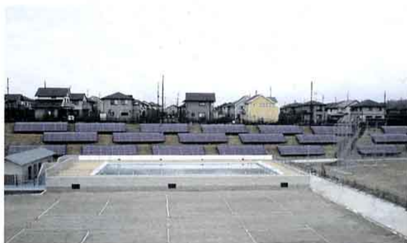
学校隣接地斜面の太陽光発電パネル
