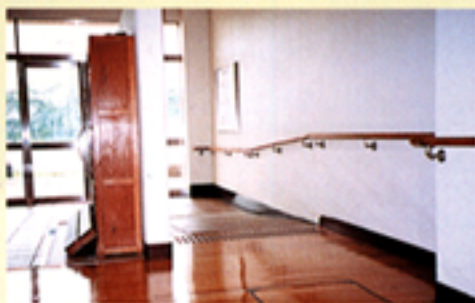
昇降口に設置されたスロープと手摺 (東京都・大田区立大森第三中学校)
