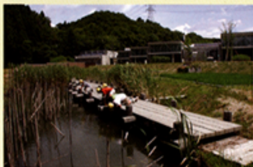
ビオトープや太陽光発電設備を備えたエコスクール (愛知県・瀬戸市立品野台小学校)
