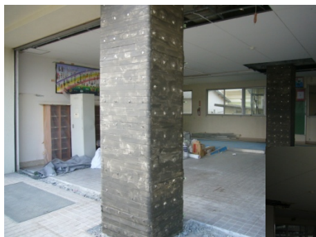
▲ 補強工事中の柱
