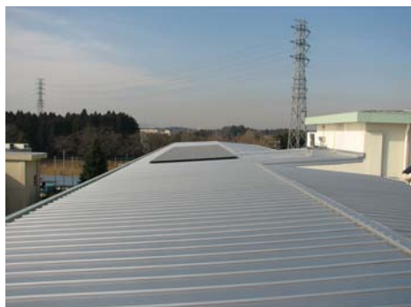
▲3階の上に設けられた屋根
