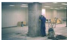
下地処理 サンダー等によりコンクリート表面の劣化層の研磨、補修を行う。
