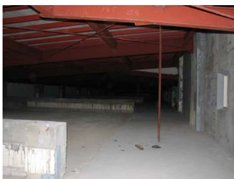
▲4階部分撤去後の屋根下地材
