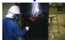
マトリックス樹脂塗布 炭素繊維シート接着樹脂を塗布する。
