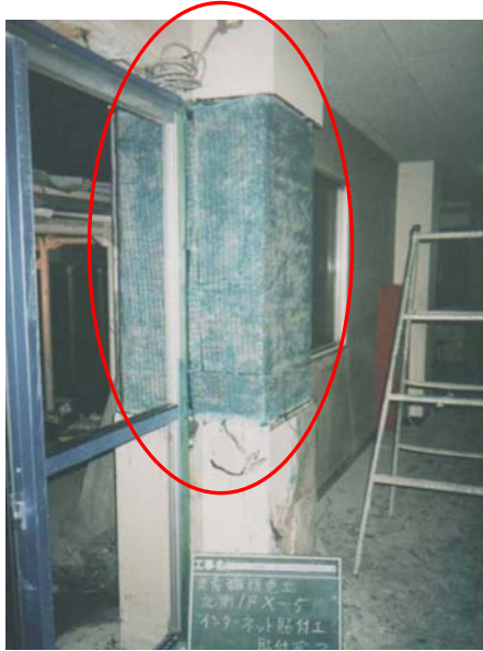
◀ 補強工事中の柱
