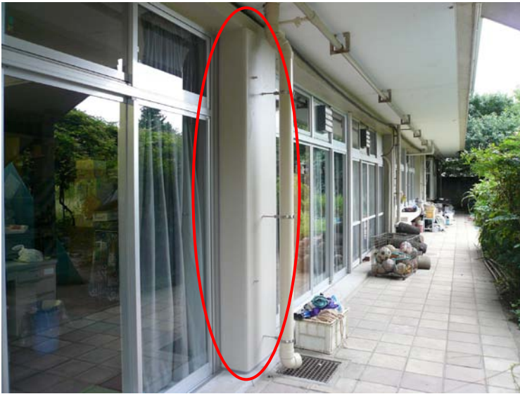
▲ 鋼板による補強後
