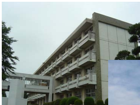
▲補強前の校舎外観(4階建)
