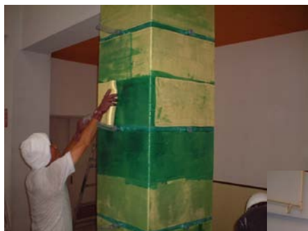
▲ 補強工事中の柱
