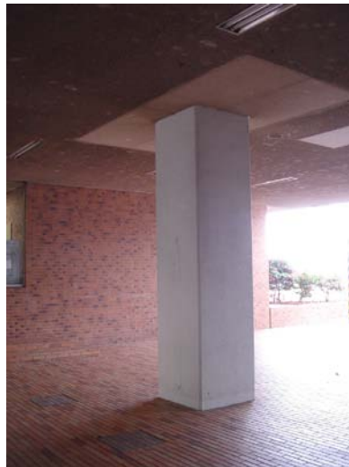
▲ アラミド繊維シートによる補強後
