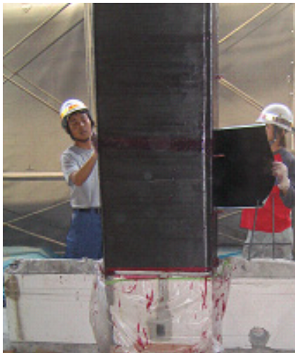
▲補強工事中の柱
