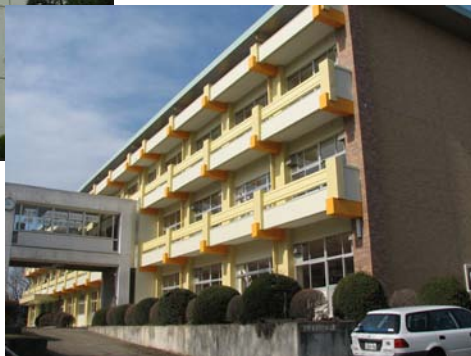
▲補強後の校舎外観(3階建)
