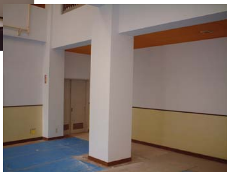
▲ アラムド繊維シートによる補強後
