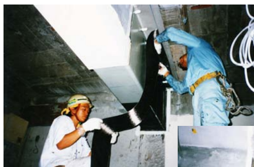
▲補強工事中の梁
