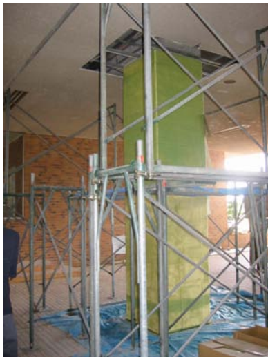
▲ 補強工事中の柱
