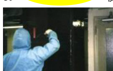
マトリックス樹脂含浸 気泡を脱泡ローラーで除去しながら、樹脂を含浸させる。
