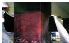
シート貼付け 炭素繊維シートを貼付ける。
