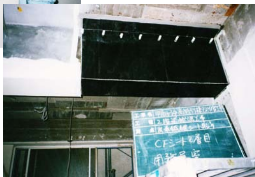
▲炭素繊維シートによる補強後
