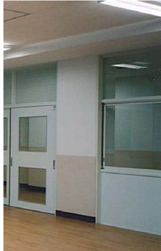
▲炭素繊維シートによる補強後
