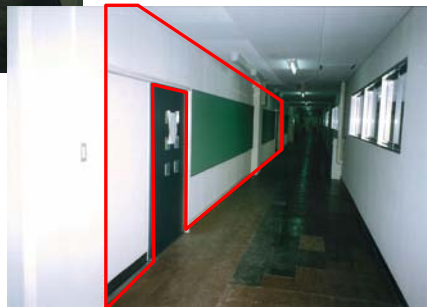
▲ 耐震壁による補強後
