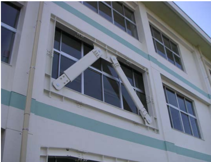
▲ 補強後の校舎外観
