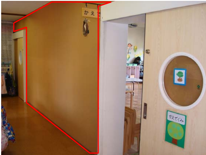
▲ 耐震壁による補強後
