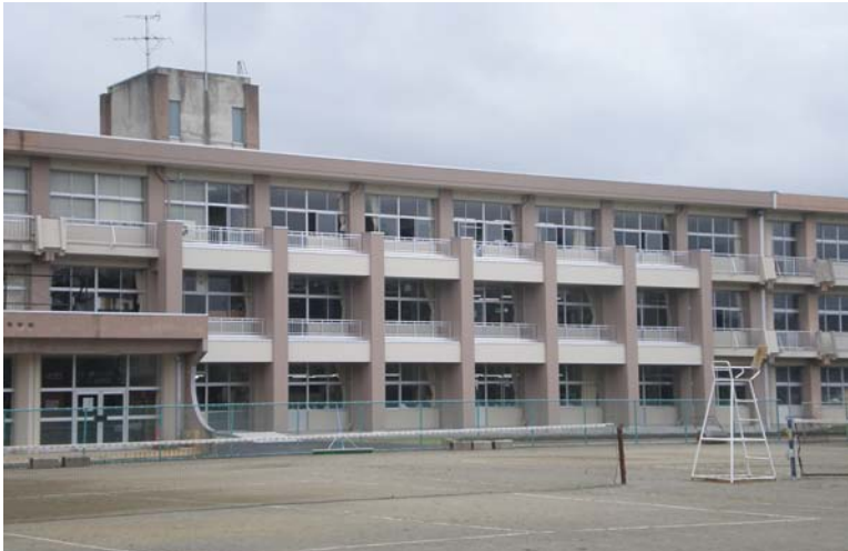
▲ 補強後の校舎外観
