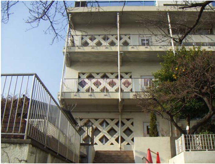
▲ 補強後の校舎外観
