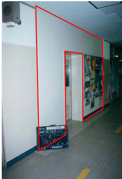
▲ 耐震壁による補強後
