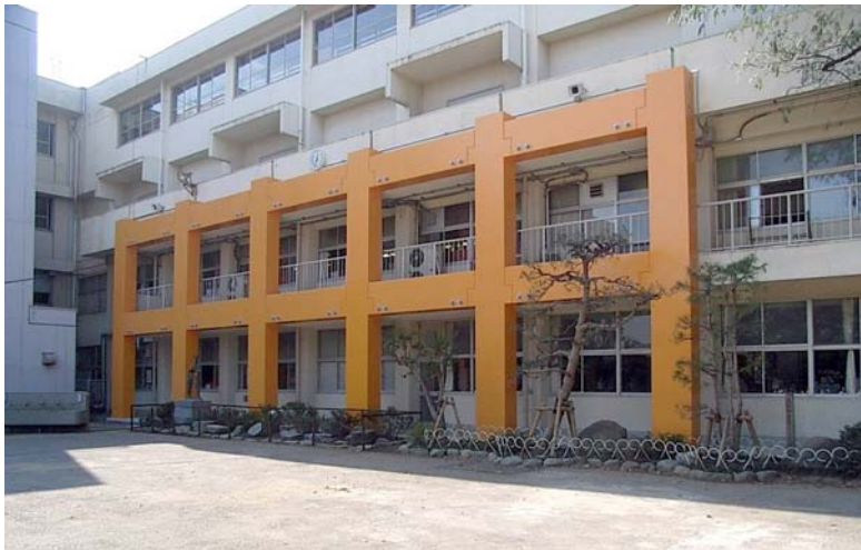
▲ 補強後の校舎外観
