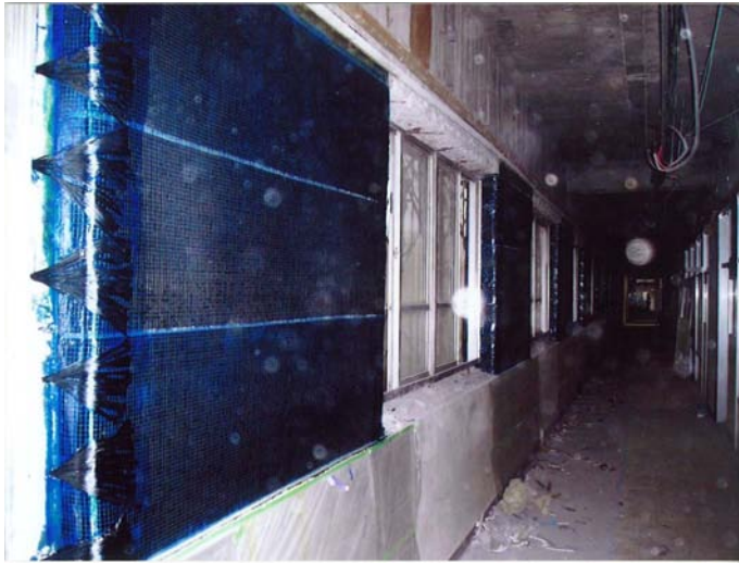
▲ 補強工事中の壁付き柱
