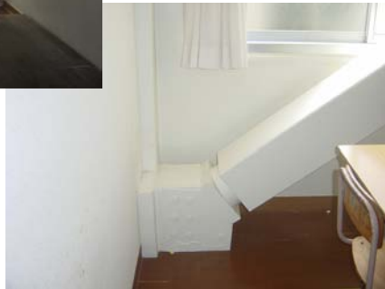
ブレース取付け部 ▶
