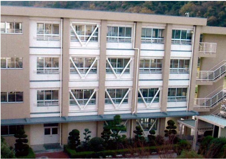
▲ 補強後の校舎外観
