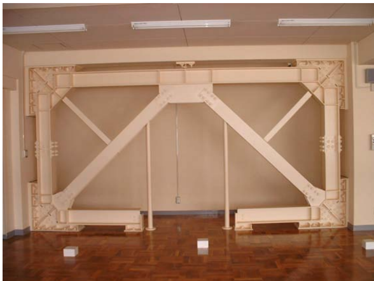
▲ ブレースによる補強後
