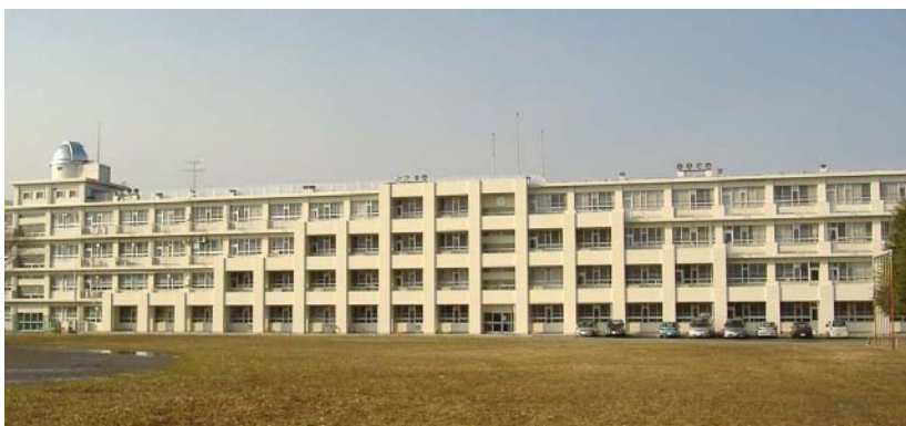
▲ 補強後の校舎外観
