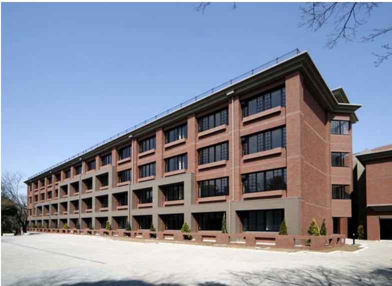
▲ 補強後の校舎外観
