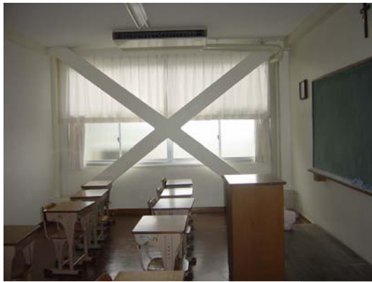
▲ ブレースによる補強後
