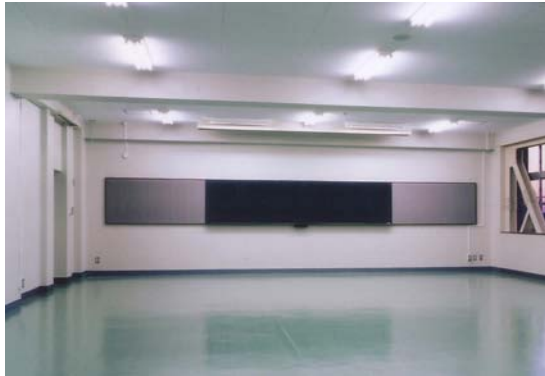
▲ 耐震壁による補強後
