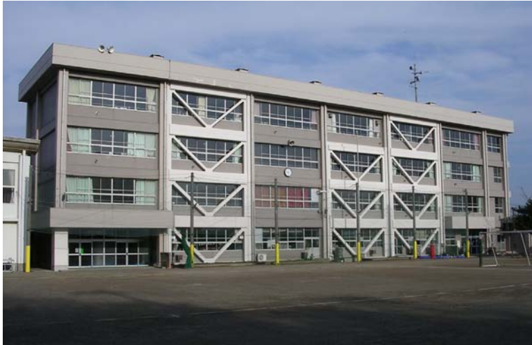
▲ 補強後の校舎外観
