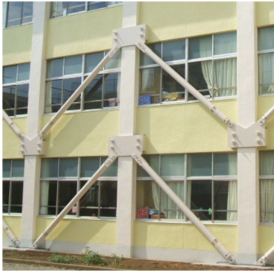
▲補強後の校舎外観
