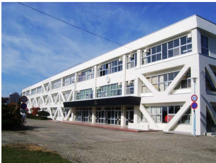
▲ 補強後の校舎外観
