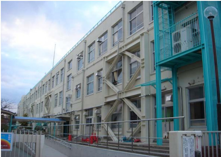
▲ 補強後の校舎外観
