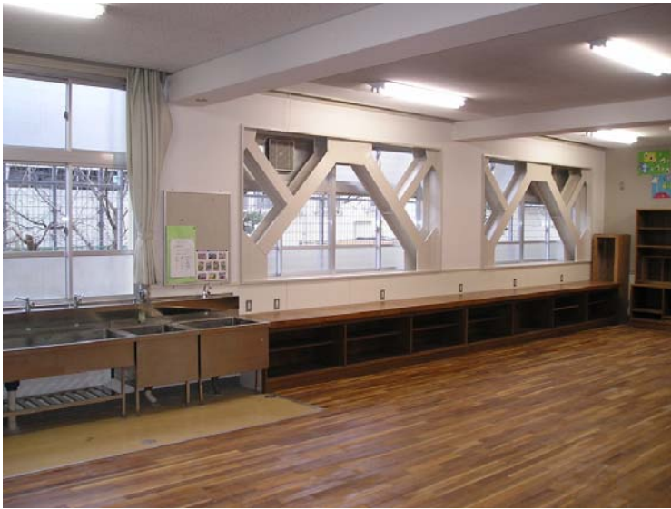
▲ ブレースによる補強後
