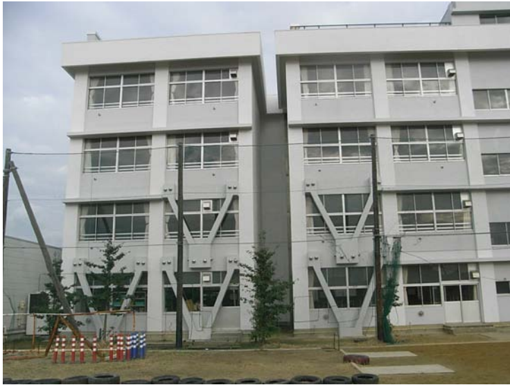
▲ 補強後の校舎外観
