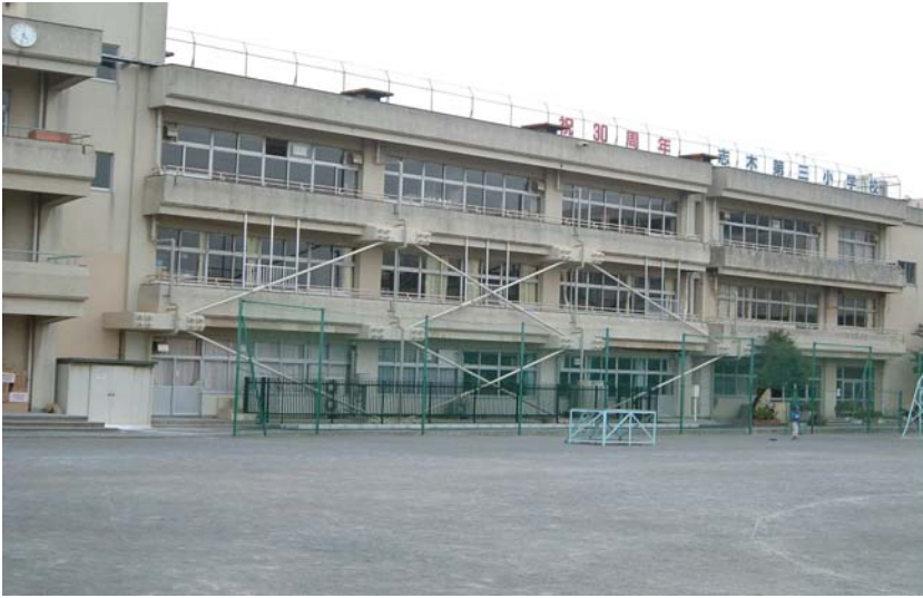
▲ 補強後の校舎外観
