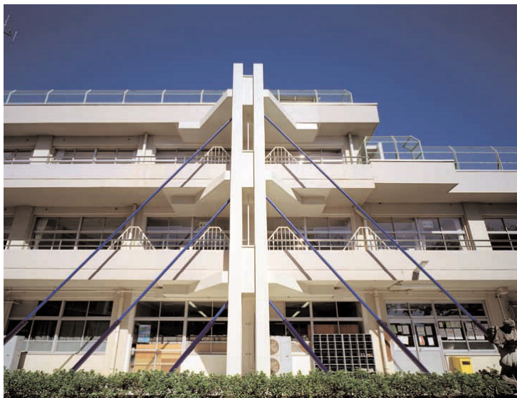
▲ 補強後の校舎外観
