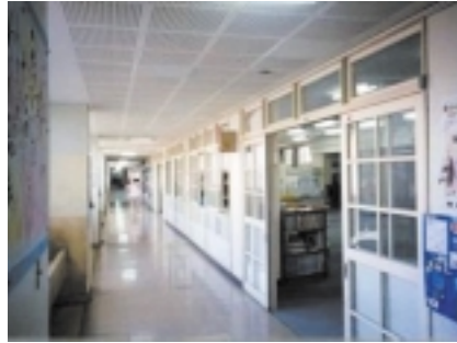
廊下との境には冷暖房区画としての間仕切りがある
