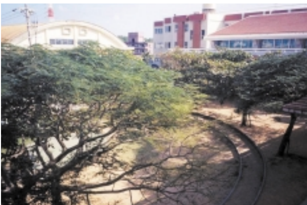
外観（増築部には勾配屋根が掛けられている）
