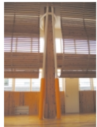
既存のRCの柱に沿わせた鉄骨丸柱
