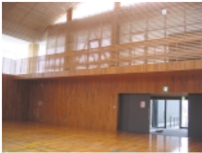
既存の床材を再利用した壁面
