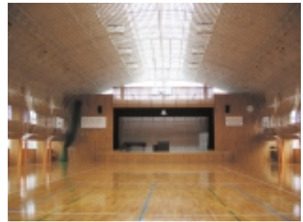
大規模な開口を設けた天井
