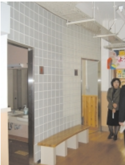
新設されたトイレ
