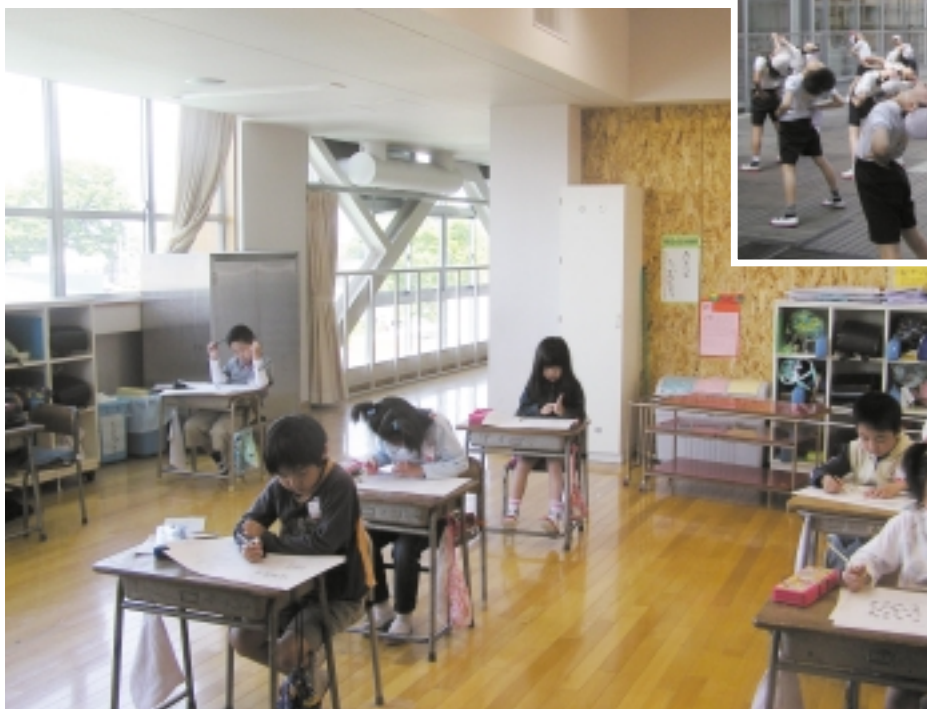
普通教室のオープン化(廊下側にみえる耐震補強部分)
