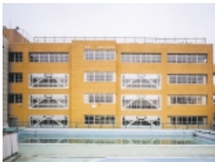
ブレース補強外観
