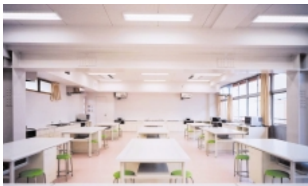
教室の界壁を撤去した梁柱をH型鉄骨で補強した家庭科教室
