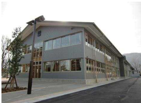
カラーガルバリウム鋼板張りの外壁
