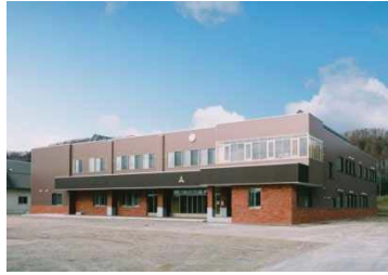
木造劣化を防ぐため外部露出を避けた外観
