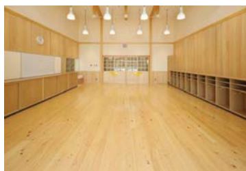
床フローリングと腰板に町内産ヒノキを使用した保育室
