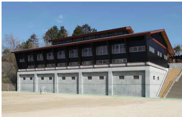
県産材焼杉板ウレタンクリア塗装品を使用し、耐久性と木材利用を両立した外壁
