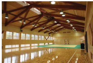
木材の接合部に金物が露出しない 温かみのある内観
