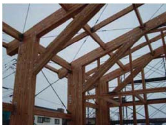
柱・梁・方杖状況
