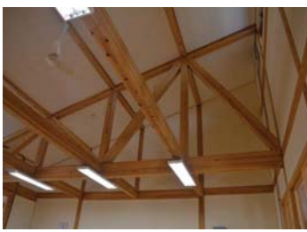
自然採光、自然通風を確保し解放感も感じられる普通教室の天井
