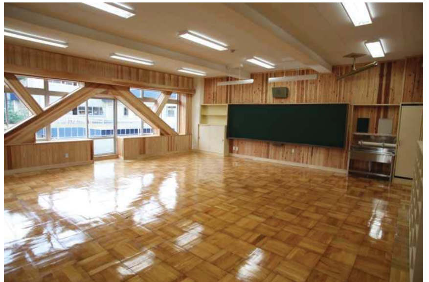
改修後の普通教室。耐震ブレースも木材で囲まれた。
