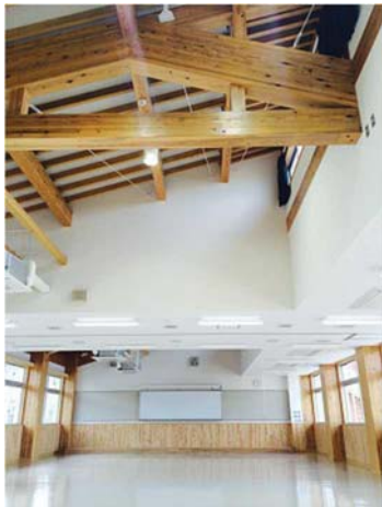
多目的に活用できる大きな空間。 ハイサイドライトからの採光によりとても明るい。
