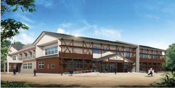
将来のメンテナンスに配慮し1階部分のみに木材を利用した外壁
