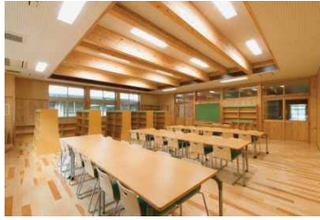
大断面の梁を見せることで、木質空間をダイナミックに演出した図書室
