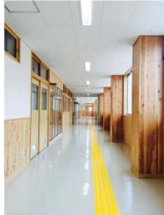
柱に県産杉を使用した廊下
